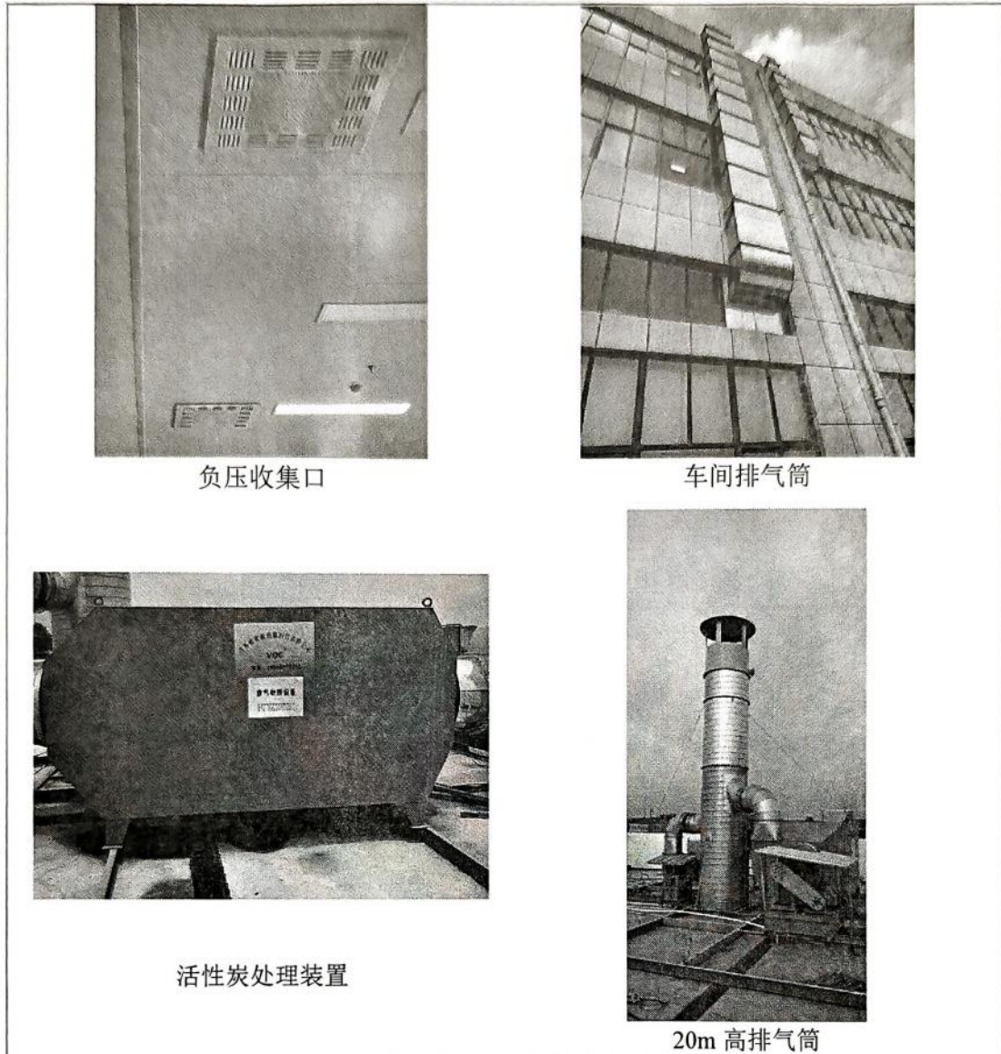
图 3-2 废气收集、处理装置及排气筒
